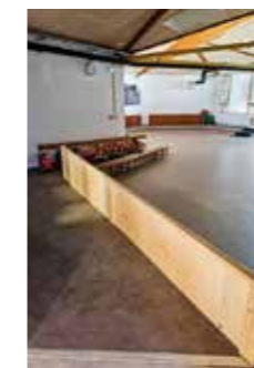
Rampe d'accès dans la salle de motricité de l'Albanne...
