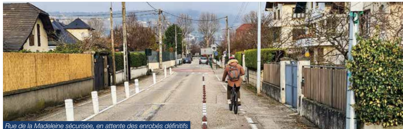
Rue de la Madeleine sécurisée, en attente des enrobés définitifs
